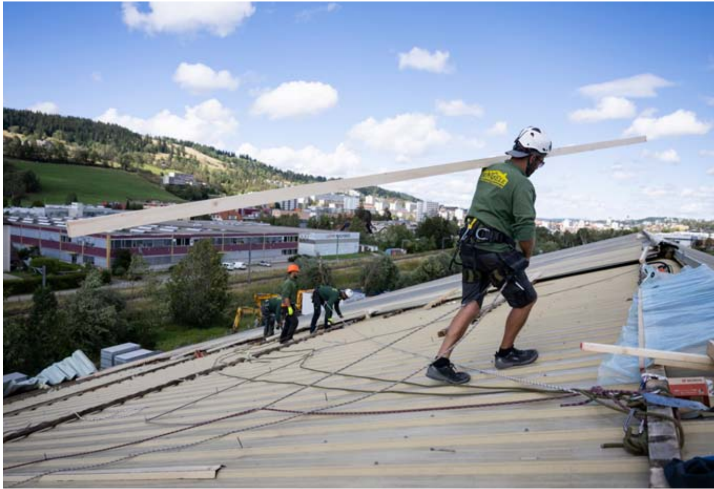
Les couvreurs sont très recherchés. Ici, une équipe de l'entreprise chaux-de-fonnière Singelé, sur les toits du XL Bowling. LUCAS VUITEL
